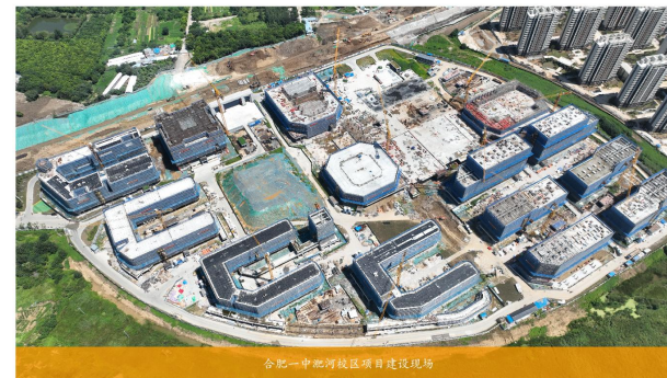
合肥一中淝河校区项目建设现场
