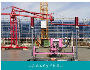
正在施工的整平机器人
