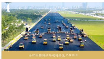
合肥园博园机场跑道修复工程项目
