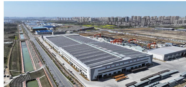
安徽建工交通智造有限责任公司厂房屋面4.96MW分布式光伏发电项目
