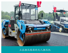
正在摊铺路面的无人摊铺机
