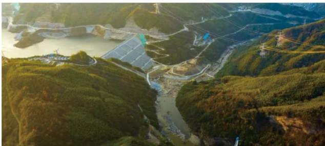
流波电站获评水利部“绿色小水电示范电站”
