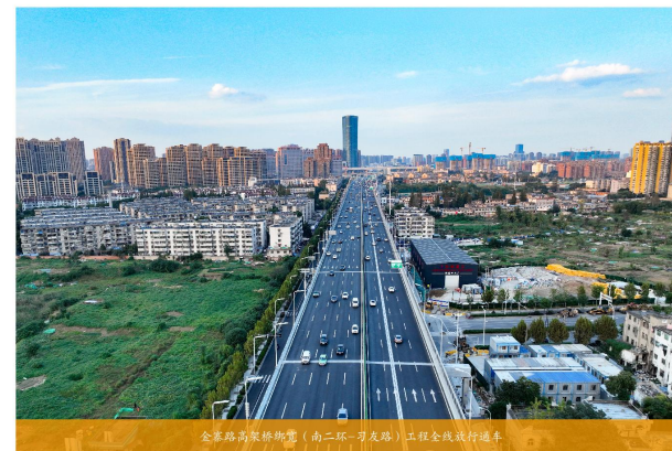
金寨路高架桥拓宽（南二环-习友路）工程全线放行通车
